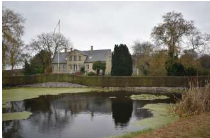
Stuehuset til "Mindegård", Hersnap Bygade 5, i gule sten. "Mindegård" er opført i 1876 og har kampestenslænger. Sammen med placeringen midt i byen foran gadekæret gør det gårданlægget bevaringsværdigt.
