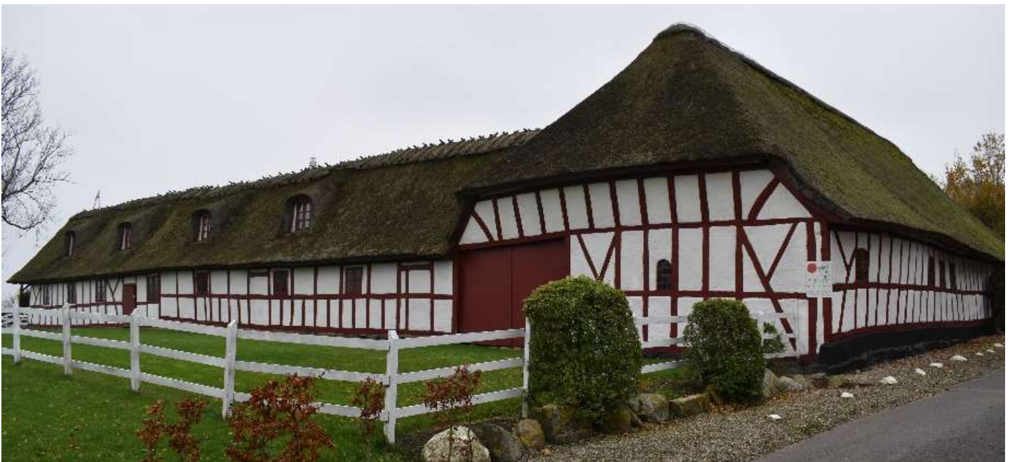
Over Kærbyvej 98, der er en firlænget bindingsværksgård med stråtag, er angiveligt opført i 1877.
