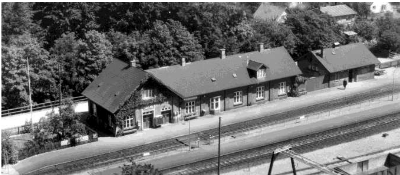
Luftfoto af Langeskov Station fra 1956. Danmark set fra Luften.
