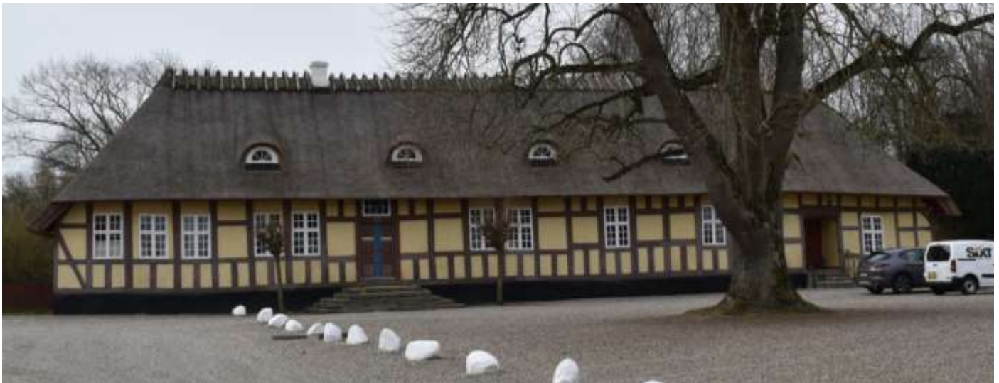
Sellebergs ”nye” hovedbygning, den gamle sydfløj. Den er ombygget i 1780 og nu fredet.
