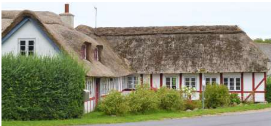
Salby Bygade 3, der er opført i bindingsværk og med stråtag i 1777 ifølge BBR.
