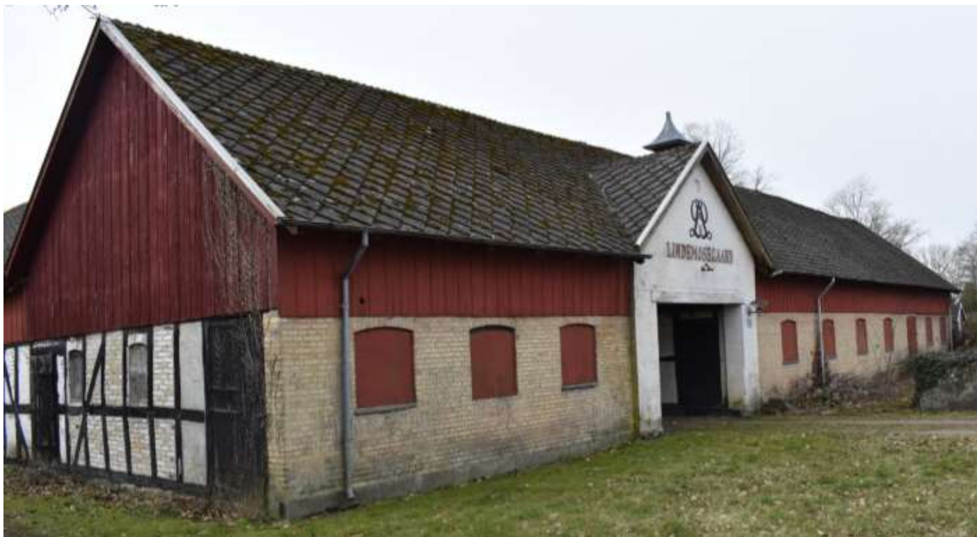
Lindemosegård, der ligger Hans Tausensgade 39, er et firlænget gårdanlæg med flere bevaringsværdier. På samme sted er der indtegnet en tolænget gård på O1-kortet fra starten af 1800. På fotoet fremgår det tydeligt, at gavlen stadig står i bindingsværk, mens facaden ud mod gaden er omsat i gule mursten.
