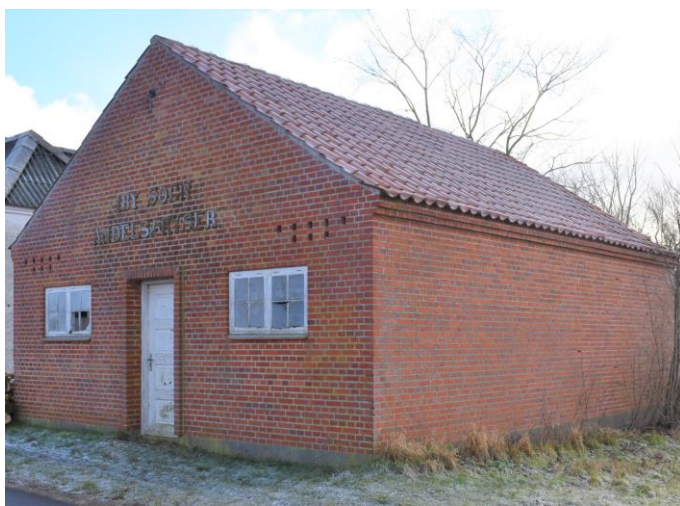
Målebakkevej 96, Viby Sognsk Frysehus, der er opført i 1952 og nedlagt 1984.
