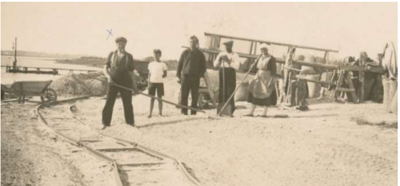
Billedet viser skalleproduktionen på Tornø, ca. 1930-1940. Ved skallegravning gravede man skaller op af den inddæmede havbund. Herefter blev skallerne tørret og reset på forskellige skalleværker. I starten blev skallerne aftaget af hønserier til hønsefoder, men man afsatte snart også til keramikindustrien. Foto: Munkebo Lokalhistoriske Arkiv.
