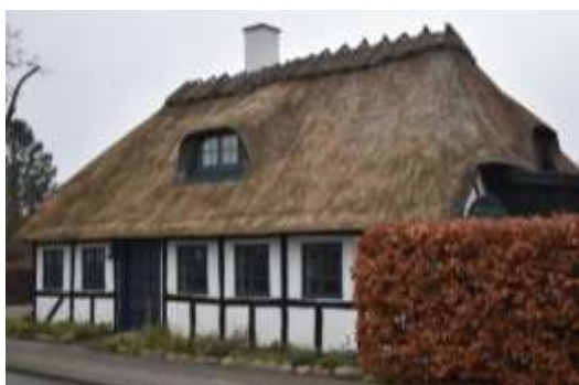
Revninge Bygade 13, der er et bindingsværksbygget hus med stråtag, er angiveligt opført i 1827.
