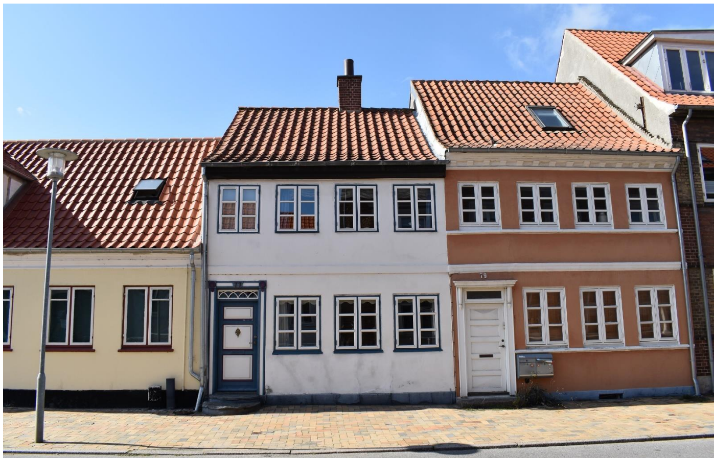
Ét af byens huse, som har fået forholdsvis høj værdi i SAVE-registreringen, er Langegade 77. Med sin fine facaderytme, smukke gadedør og bevarede skorsten har huset opnået en samlet værdi på 3.
