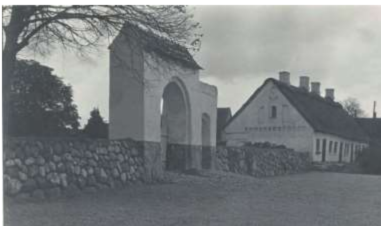
Foto fra 1972 af den fredede Mesinge Kirkelade, der i dag bliver drevet som café og dermed stadig er en aktiv del af bymiljøet. Det er vigtigt at bevare kulturmiljøet omkring præstegården, kirken og kirkeladen for eftertiden. Foto: Mesinge Sogns Lokalhistoriske Arkiv.
