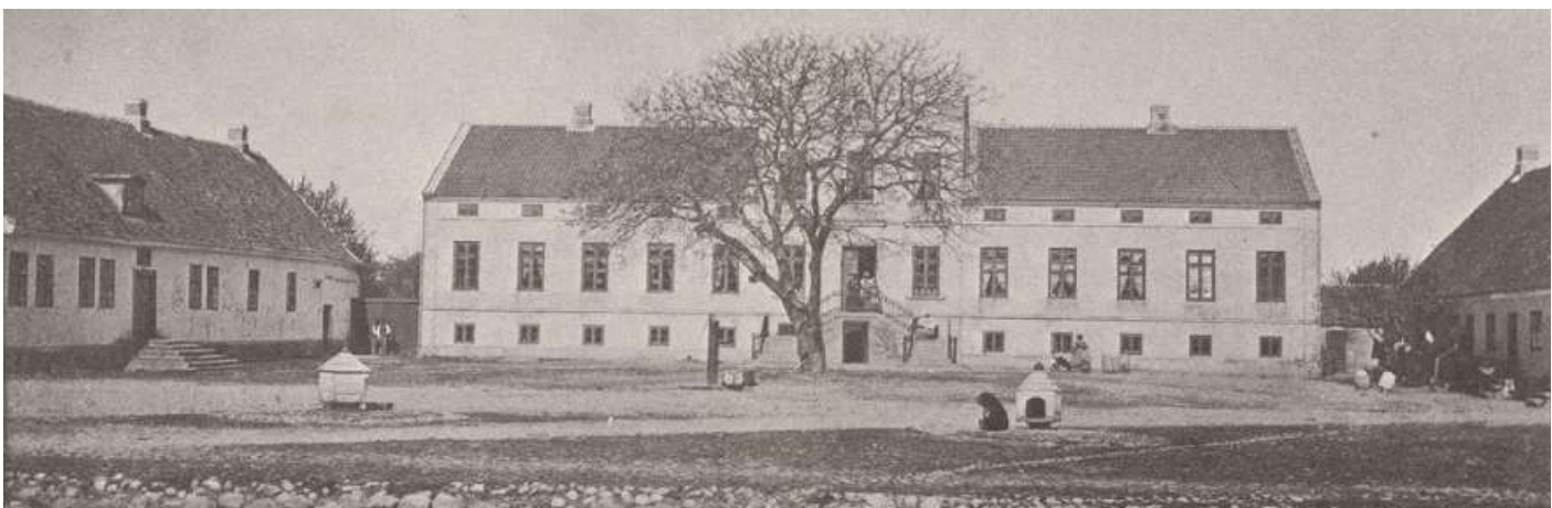
Foto fra 1865 af den gamle hovedbygning, der var opført i 1845 og blev revet ned i 1961. Foto: Langeskov Lokalhistoriske Arkiv.
