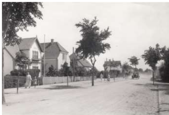
Klintevej udgjorde en uasfalteret landevej ca. 1920.
