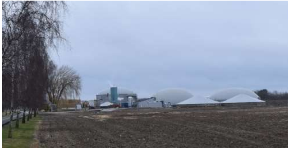
Biogasanlæg set fra vejen i mørk dag i marts, hvor anlægget næsten går i et med himlen i det sparsomme lys. I modsætning til solskinsdage, hvor anlægget og kuplerne tydeligt kan ses glimtende – også fra Munkebo bakke. Med en bræmme af beplantning rundt om anlægget vil det være grønt i mere end én henseende.
