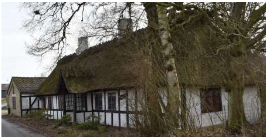
Bremerskovvej 4, der angiveligt er opført i 1777. Huset er i bindingsværk og har bibeholdt stråtag og to skorstene.
