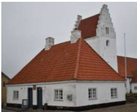
Revninge Hospital, der er fredet og danner sit eget miljø med kirken. Hospitalet ligger Revninge Bygade 119 og er opført i 1736 af Margrethe Levetzau af Lundsgård Gods. I dag anvendes det af menighedsrådet.
