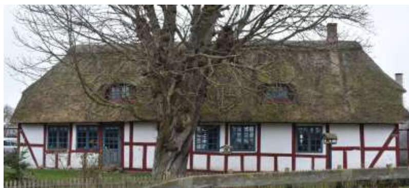
Fynshovedvej 692, der er en bindingsværksbygget, firlænget gård opført i 1857. Stuehuset har stråtag, mens længerne har pladetag.
