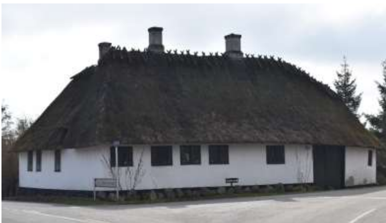
Rønninge Bygade 26, der er et fredet bindingsværkshus. Stuehuset er opført i 1810 og længerne i 1850. Det trelængede anlæg følger gadeforløbet og har stråtag samt bibeholdt sine skorstene.
