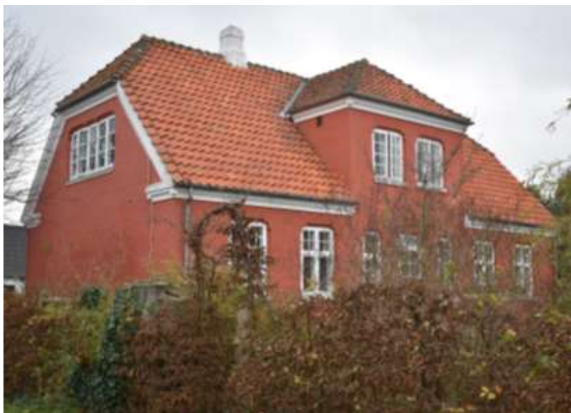
Birkebjergvej 96 var tidligere landbrug og i dag anlægsgartneri.
