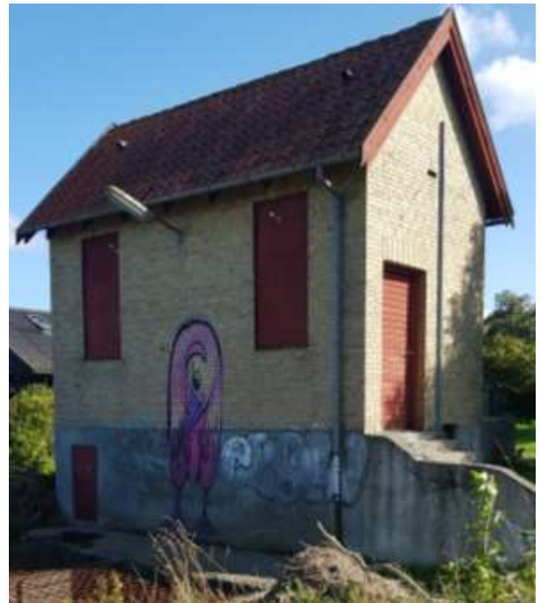
Pumpehuset ved Bådsbæk.
