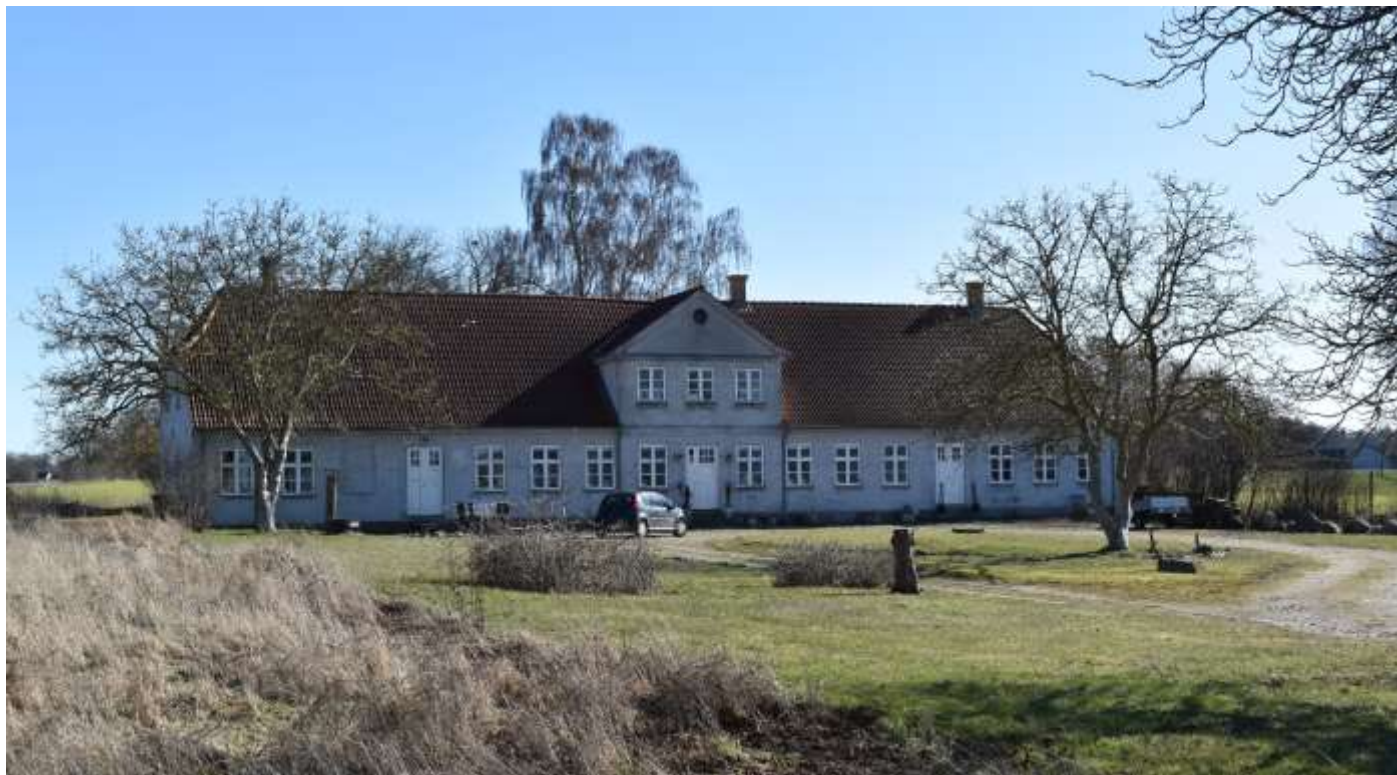
Radstrupvejen 3. Stuehuset fremstår stadig harmonisk, men de manglende længer gør, at gårdanlægget som helhed ligger mere tilbagetrukket fra vejen.
