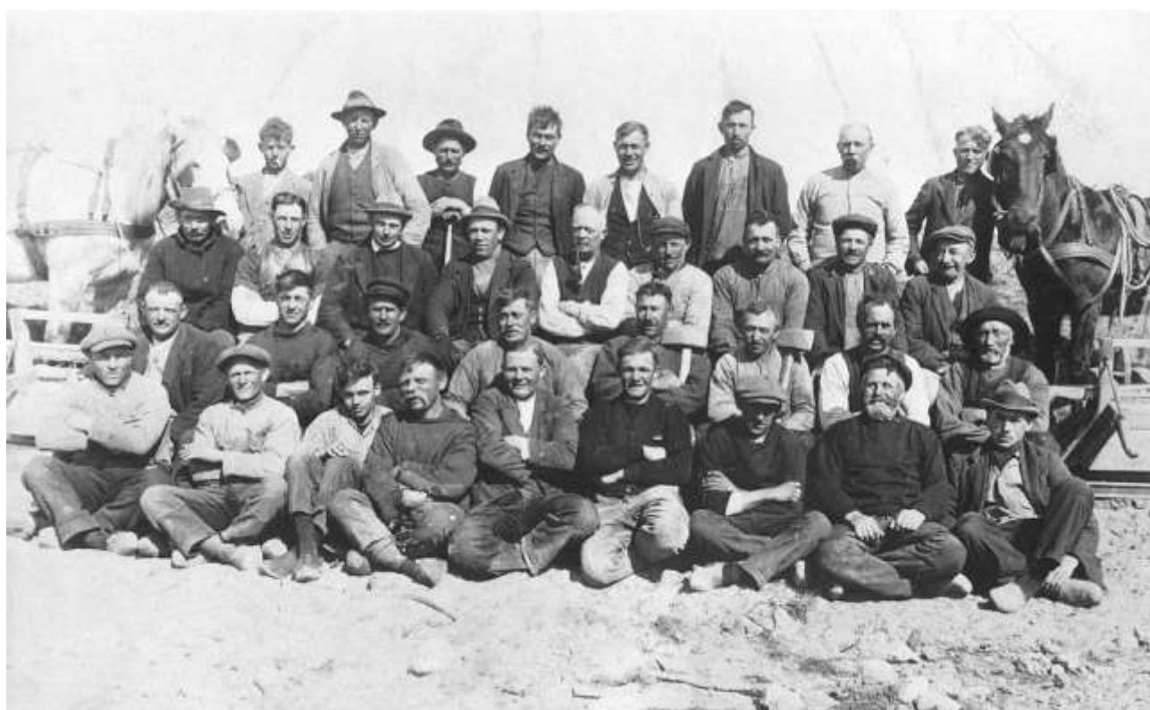
Arbejdsmandskab ved Vigerø-Lindøinddæmningen 1921. Inddæmningen gav anledning til, at der opstod et nyt ejerlav, Vigerø-Lindøinddæmningen. Foto: Munkebo Lokalhistoriske Arkiv
